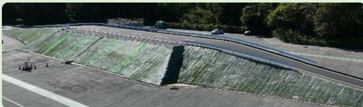
※中間貯蔵施設での道路盛土実証
