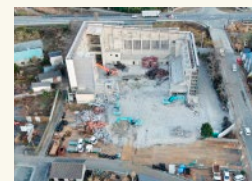
双葉町公民館・体育館の解体作業
