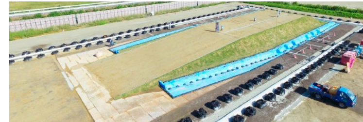
南相馬市小高区東部仮置場の試験盛土の様子(2017年9月撮影)
