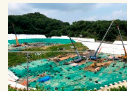
特定廃棄物埋立処分施設
