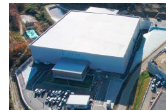
廃棄物貯蔵施設(双葉1工区)
