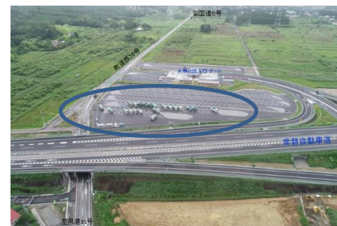
大熊IC車両待機場
