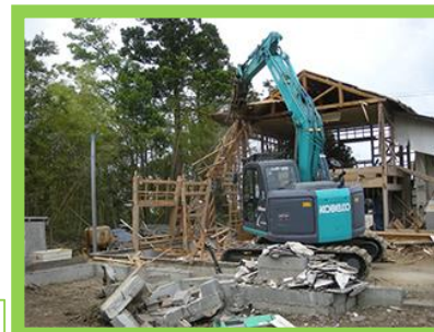
被災家屋等の解体
