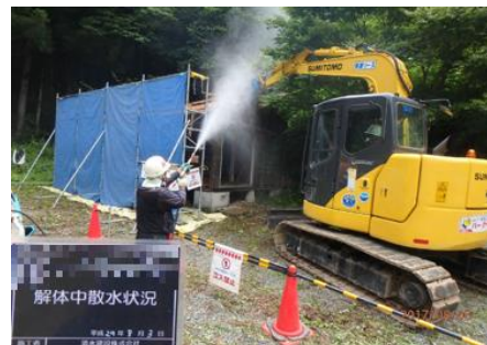
被災家屋等の解体の様子
