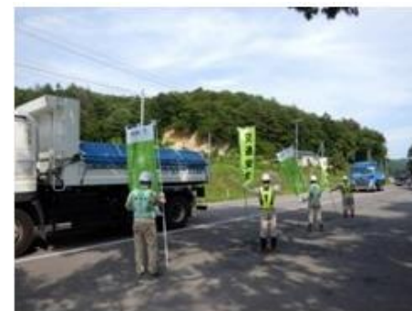
車両走行状況の現場確認(国道288号)
