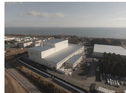
大熊町の仮設焼却施設
